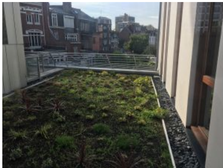
Toiture végétale à l'IESEG Lille, source : Cabinet CHEROUTRE, 2016
