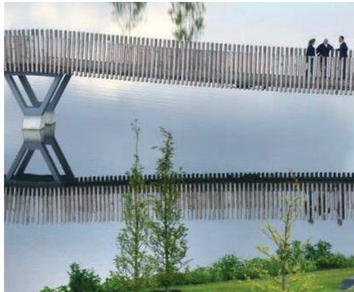
Passerelle piétonne et cyclable L'entrée ouest jouant le rôle de transition entre le contexte urbain et le parc est mise en scène par la création d'une passerelle élégante réservée aux modes doux. Source : Pont piétonnier à Tirschenreth en Allemagne
