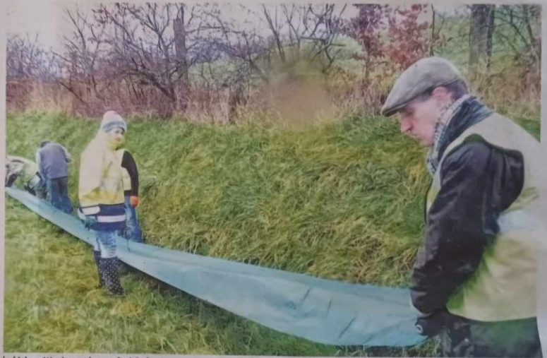
La bâche a été mise en place au fond du fossé
